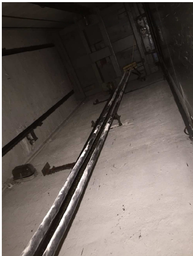
Szyb windy z widokiem z widocznym nadszybiem
